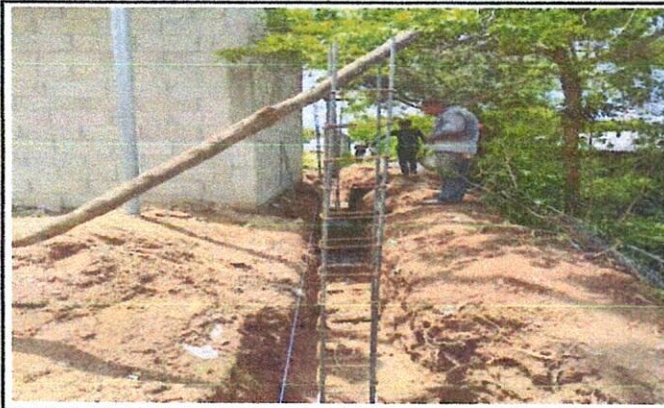
Foto 1: Inicio de trabajo del muro perimetral
