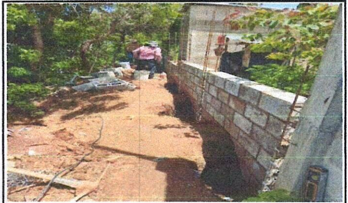
Foto 2: avance del muro perimetral
